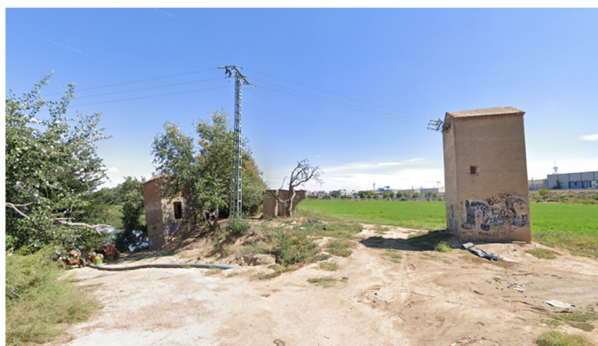
Fotografía de emplazamiento en estado inicial.
