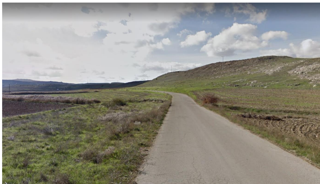
Figura: Fotografía de inicio del trazado de la carretera camino de Palancares. Fuente: Proyecto de acondicionamiento.
