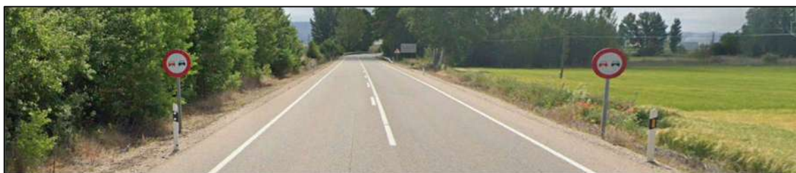
Prohibición de adelantar en el sentido ascendente de pks 320 metros antes de llegar a la intersección (hacia Teruel)
