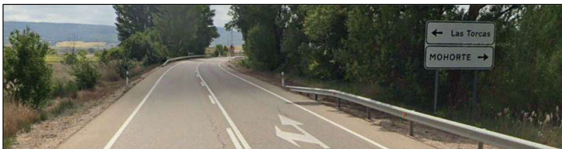
Cartel que dispone de visibilidad de decisión pues hay una recta anterior a este punto de longitud superior a 250 metros y con pendiente longitudinal ascendente de 1%
