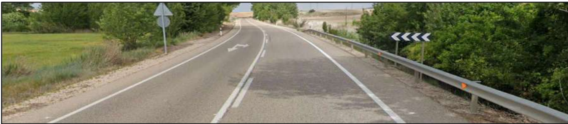
Se permite el adelantamiento en el sentido descendente de pks una vez pasados unos 75 metros de la intersección (hacia Cuenca)
