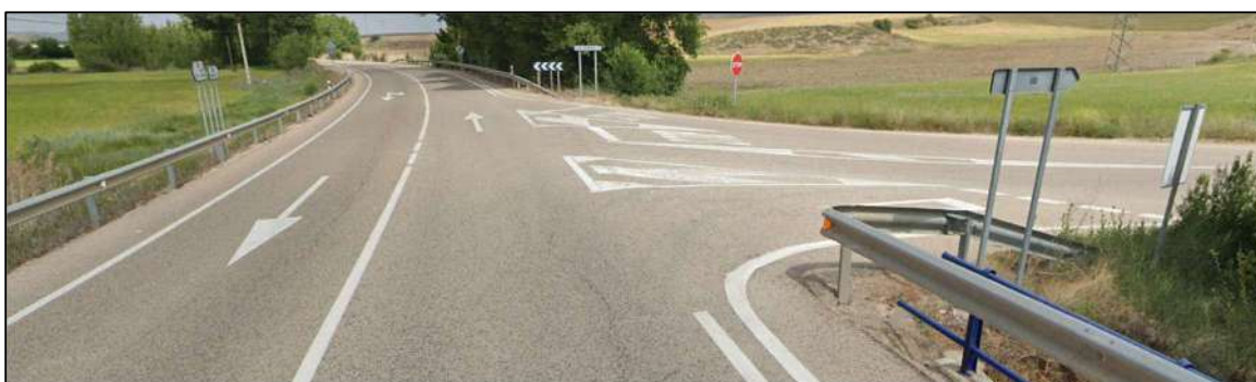
Vista en dirección a Cuenca de la intersección de la carretera N-420 con camino de los Palancares
