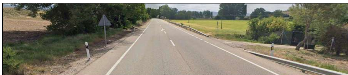
Acceso a propiedad privada. Margen derecha. Sentido ascendente. Situado a una distancia de 425 metros de la intersección del camino de Palancares (2)
