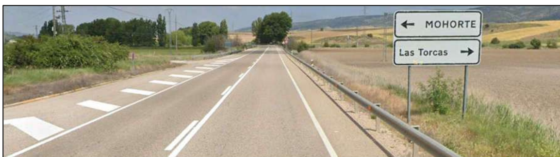
Cartel que dispone de visibilidad de decisión pues hay una recta anterior a este punto de longitud superior a 250 metros y con pendiente longitudinal descendente de 1%
