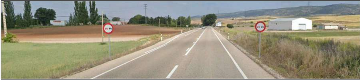
Prohibición de adelantar en el sentido descendente de pks 500 metros antes de llegar a la intersección (hacia Cuenca)
