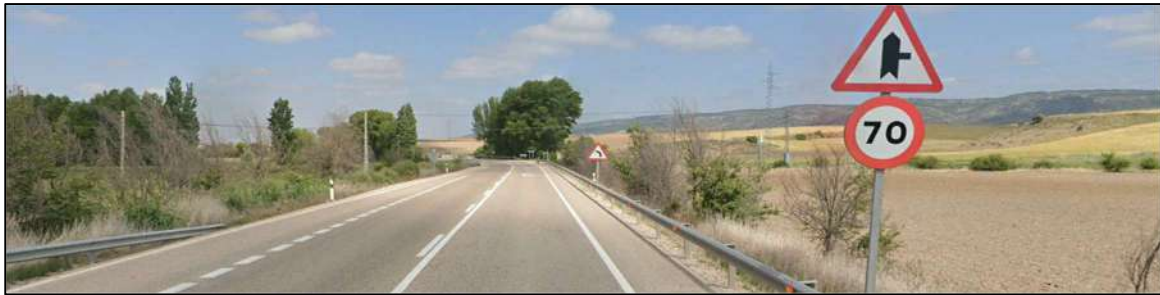
Visibilidad disponible a 150 m de la intersección. Sentido descendente de pks (hacia Cuenca)
