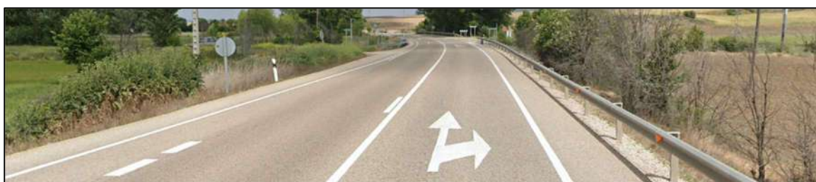
Visibilidad disponible a 100 m de la intersección. Sentido descendente de pks (hacia Cuenca)
