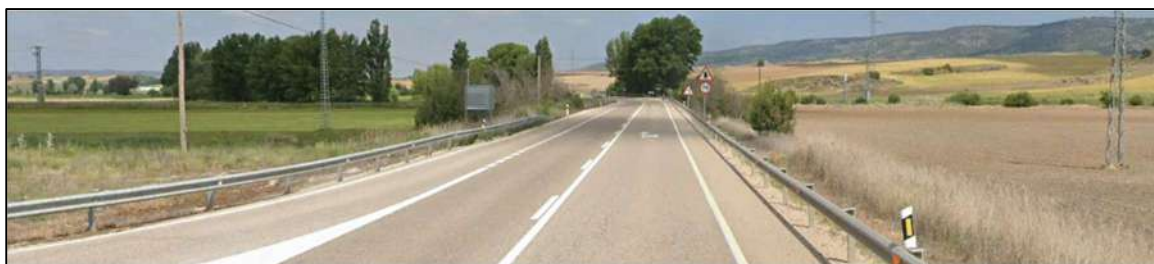
Visibilidad disponible a 230 m de la intersección. Sentido descendente de pks (hacia Cuenca)
