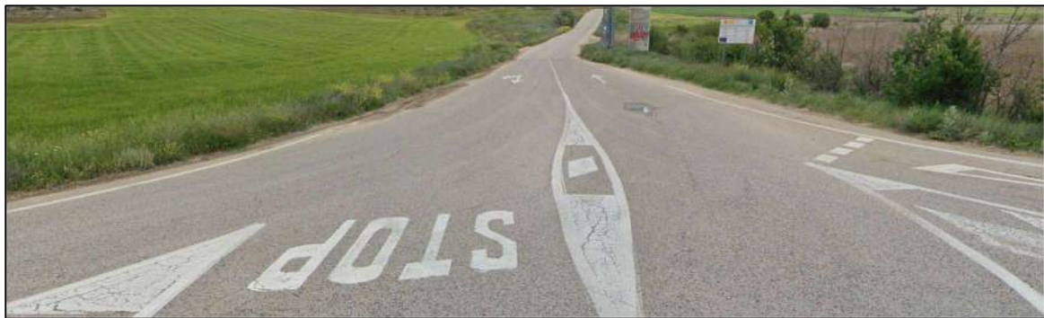
Vista desde la intersección con la carretera N-420 hacia el camino de los Palancares
