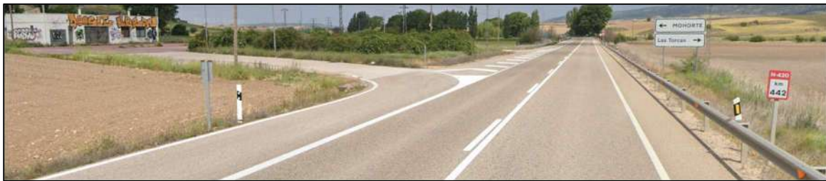
Acceso a N-420 desde estación de servicio desmantelada. Margen izquierda. Sentido descendente. Situado a una distancia de 300 metros de la intersección del camino de Palancares. Incluye cuña y ramal de entrada (6)
