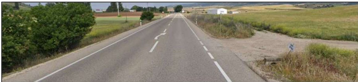
Acceso a camino. Margen derecha. Sentido descendente. Situado a una distancia de 595 metros de la intersección del camino de Palancares (7)
