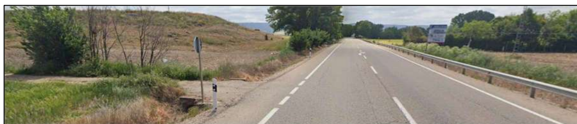
Acceso a camino. Margen izquierda. Sentido ascendente. Situado a una distancia de 515 metros de la intersección del camino de Palancares (1)
