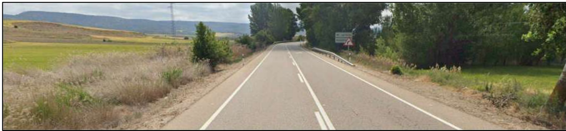
Visibilidad disponible a 230 m de la intersección. Sentido ascendente de pks (hacia Teruel)
