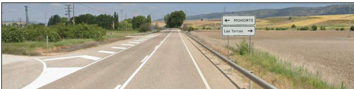
Visibilidad disponible a 300 m de la intersección. Sentido descendente de pks (hacia Cuenca)
