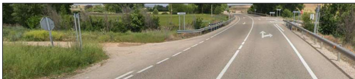
Acceso a camino. Margen izquierda. Sentido descendente. Situado a una distancia de 40 metros de la intersección del camino de Palancares (4)
