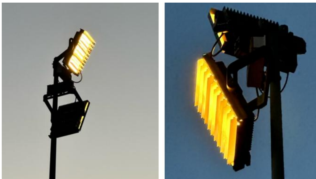
Foto 3-12. Proyector del parking en Puy du Fou España con paralúmenes en 2025 con FHSinst > 5%. (Fuente: estudio de Control y vigilancia de la contaminación lumínica en la fase de operación del Parque Temático Histórico Puy du Fou España, Toledo. Año 2025).
