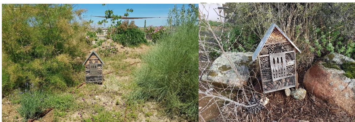
Foto 3-47. Hoteles para insectos ubicados en zonas con presencia de vegetación del Parque. En la foto de la izquierda se puede apreciar como parte de la estructura del hotel se ha visto dañada por la humedad.
