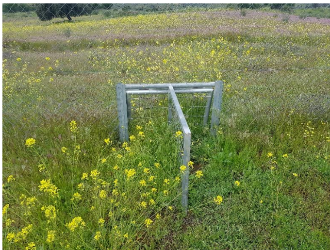
Foto 3-19. Puerta basculante con exceso de vegetación.
