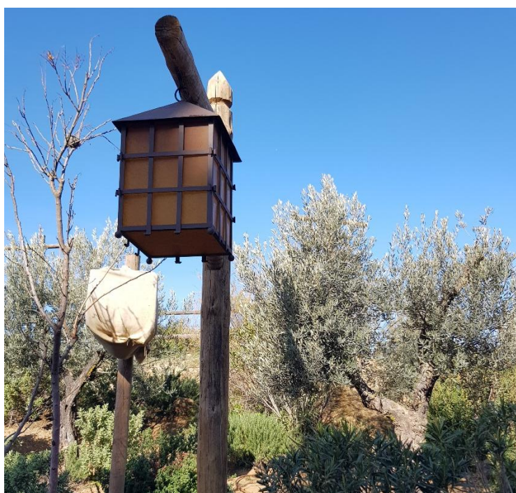
Foto 3-11. Ejemplo de una luminaria instalada en los viales del área de visitantes del Parque.
