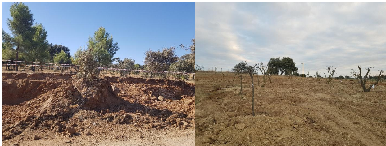
Foto 3-27. Izquierda: conservación de una encina dentro de los trabajos realizados para la ampliación de vestuarios en "El Sueño de Toledo". Derecha: punto de trasplante de pies extraídos.
