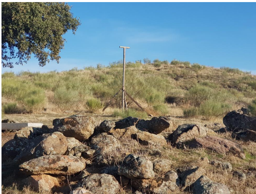
Foto 3-42. Posadero para aves instalado en el interior del Parque, en una zona alejada del área de visitantes. En la base se observan varios troncos dispuestos provisionalmente para estabilizar la estructura durante su instalación y el fraguado del hormigón, los cuales fueron retirados una vez garantizada su correcta fijación.
