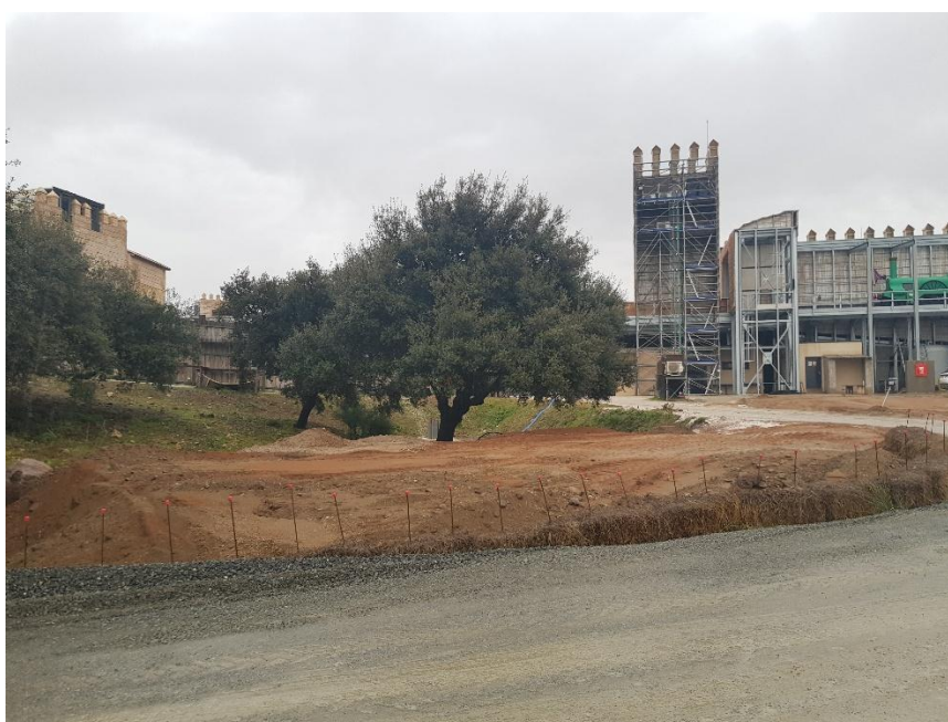
Foto 3-10. Inicio de los trabajos de reperfilado del terreno en el entorno de la charca de acumulación de sílice.
