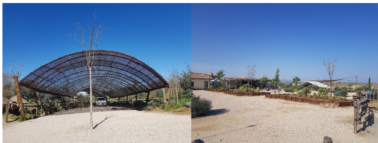
Foto 3-16. Izquierda: nueva pérgola instalada en uno de los viales internos del Parque. Derecha: lonas y toldos instalados en el área de descanso de los empleados.
