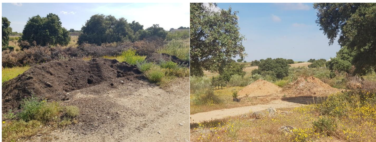
Foto 3-36. Izquierda: acopio de abono orgánico ubicado en las inmediaciones de “La Venta del Gato”, dispuesto directamente sobre terreno natural y sin sistema de impermeabilización ni cubrición. Derecha: acopio de tierras.
