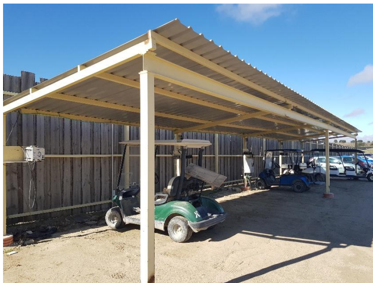
Foto 3-2. Estacionamiento y punto de carga de vehículos eléctricos utilizados por el personal.
