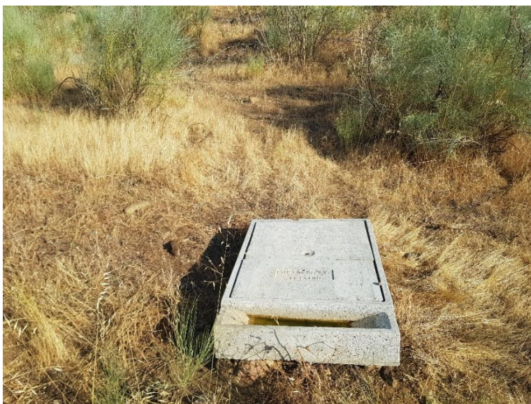
Foto 3-45. Bebedero instalado en el Parque.
