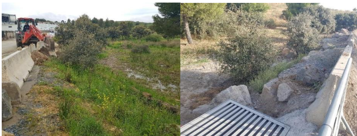
Foto 3-8. Izquierda: construcción del refuerzo de las barreras físicas instaladas inicialmente. Derecha: barrera reforzada y arenero instalado.
