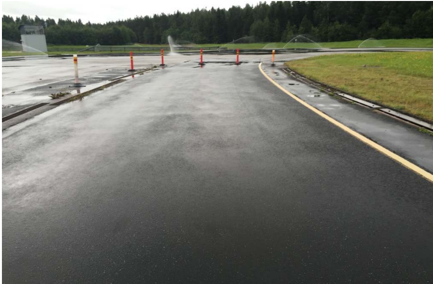
Pista de manejo sobre agua. Centro de Pruebas Nokian Tyres en Nokia, Finlandia
