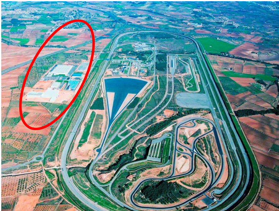
Instalación de Idiada (Tarragona) tras varios años de explotación
