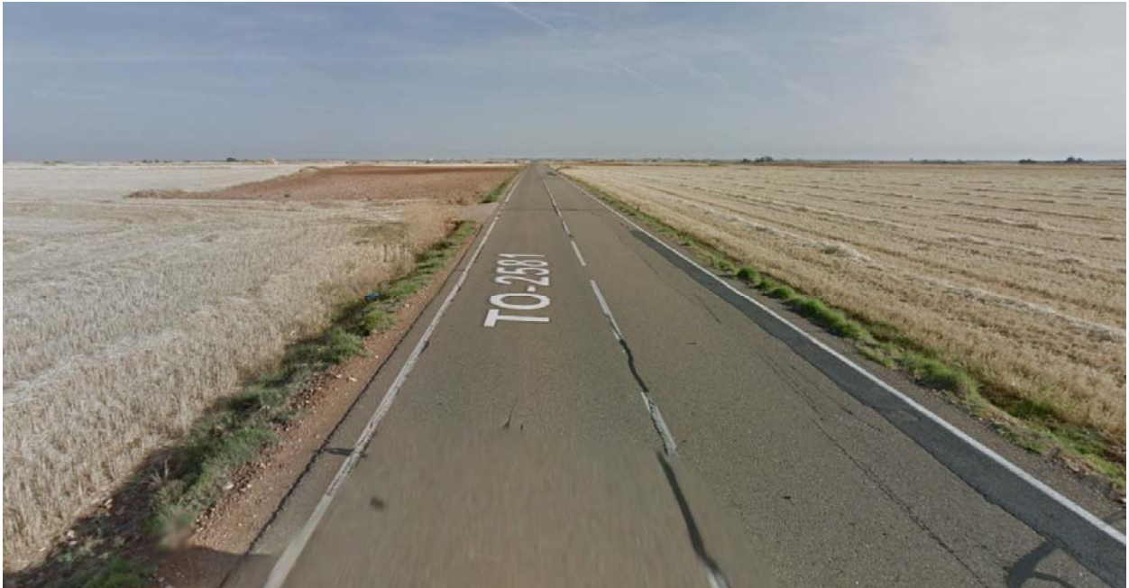
Vista general de la ubicación de la futura intersección con la carretera TO-2581, en sentido norte
