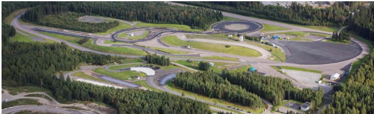
Vista aérea del Centro de Pruebas Nokian Tyres en Nokia, Finlandia
