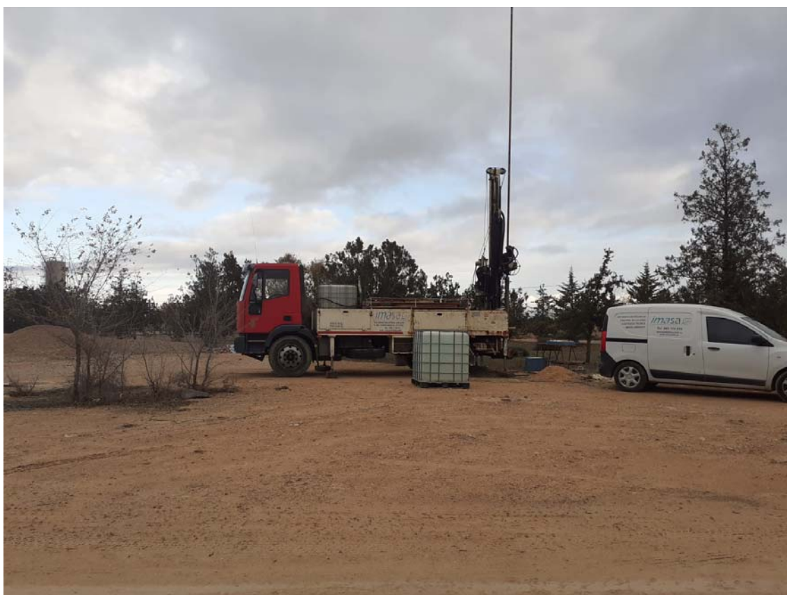
Fotografía 3.1. Maniobras de avance y realización de ensayos in-situ en el S1.
