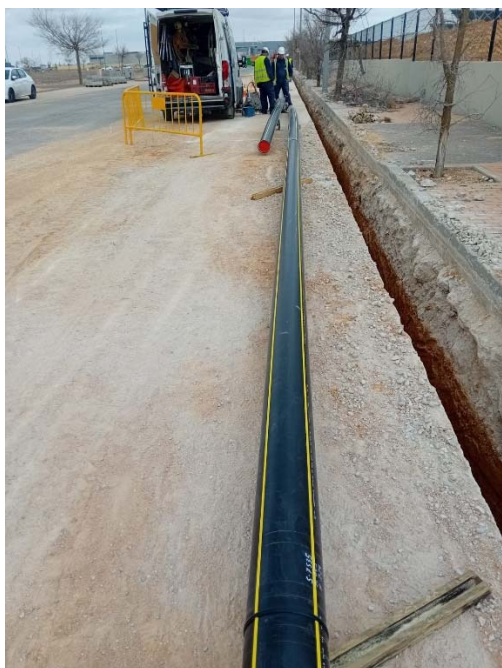
9. Colocación tubería gas vial J
