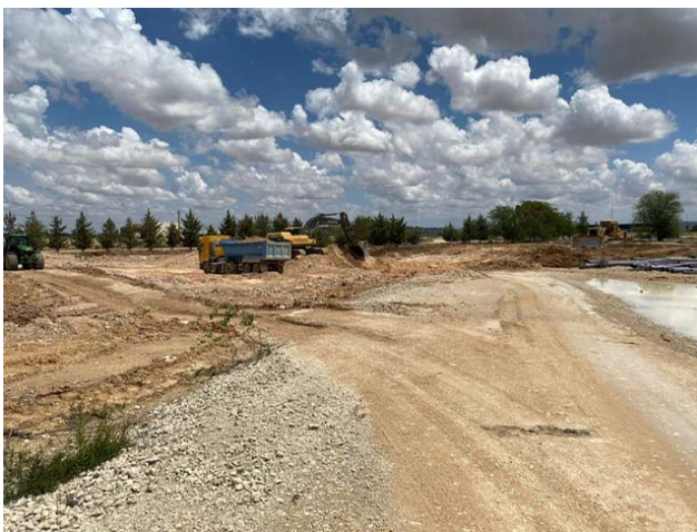
5. Zona balsa. Inicio excavación vaciado
