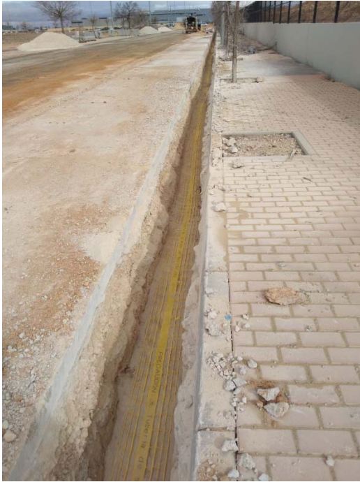
17. Zanja gas. Señalización zanja. Vial J
