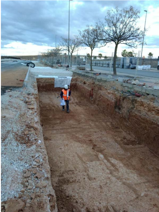
19. Excavación depósito drenante vial D.
