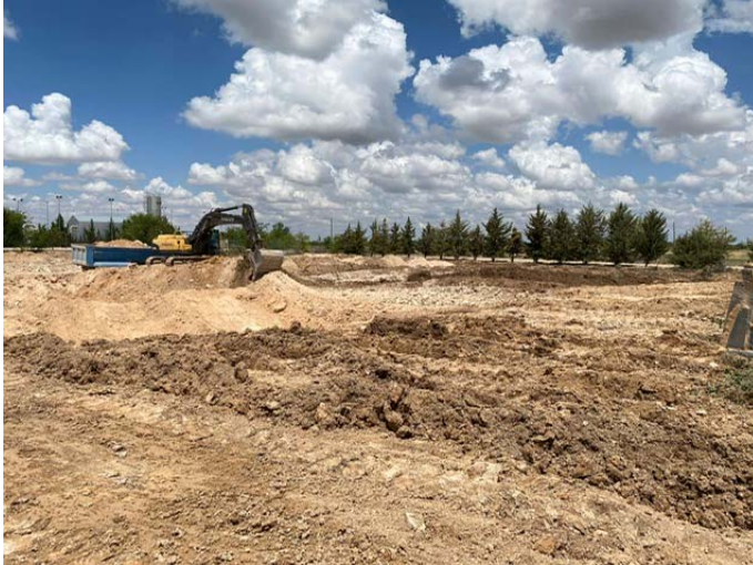
10. Zona balsa. Inicio excavación vaciado
