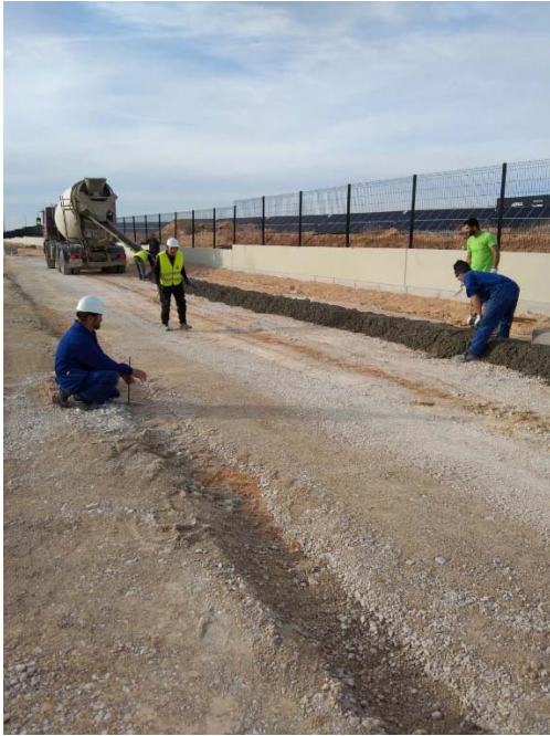
5. Colocación bordillo acerado permeable vial D
