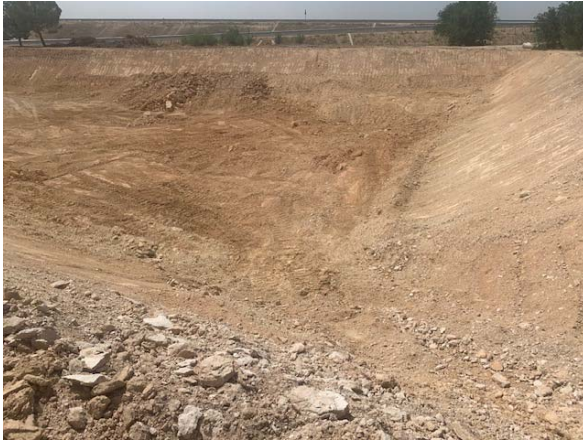
4. Excavación balsa.
