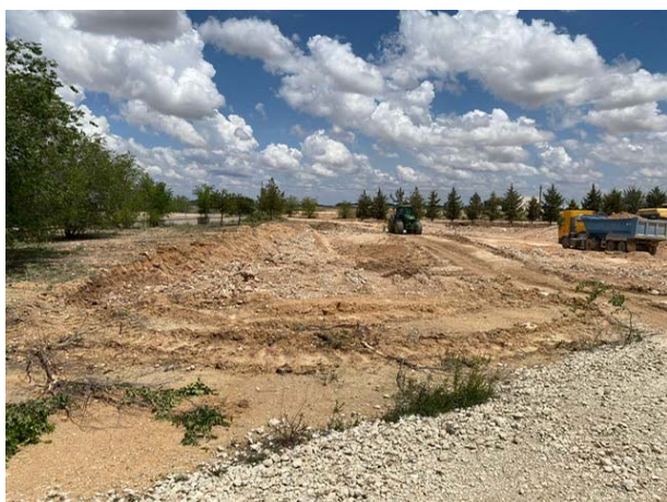
8. Zona balsa. Inicio excavación vaciado
