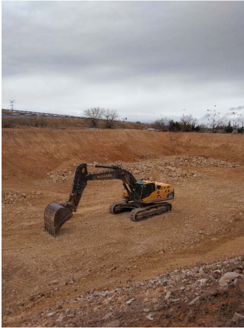
37. Excavación balsa. La máquina cuando termina se queda en el tajo.
