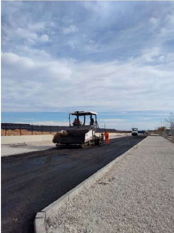
3. Asfaltado parking vial D
