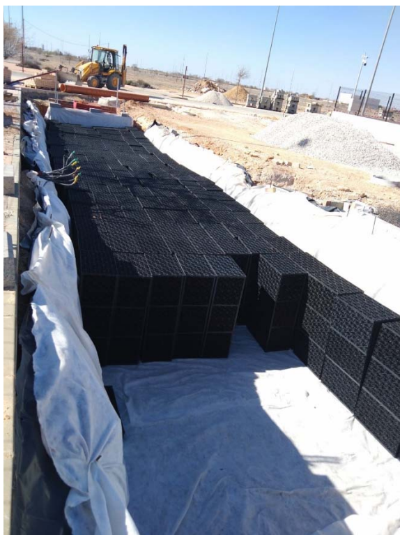
11. Depósito drenante parking vial D
