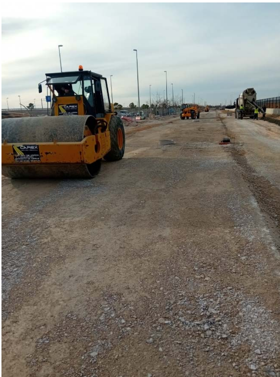
34. Compactado sub base parking vial D.
