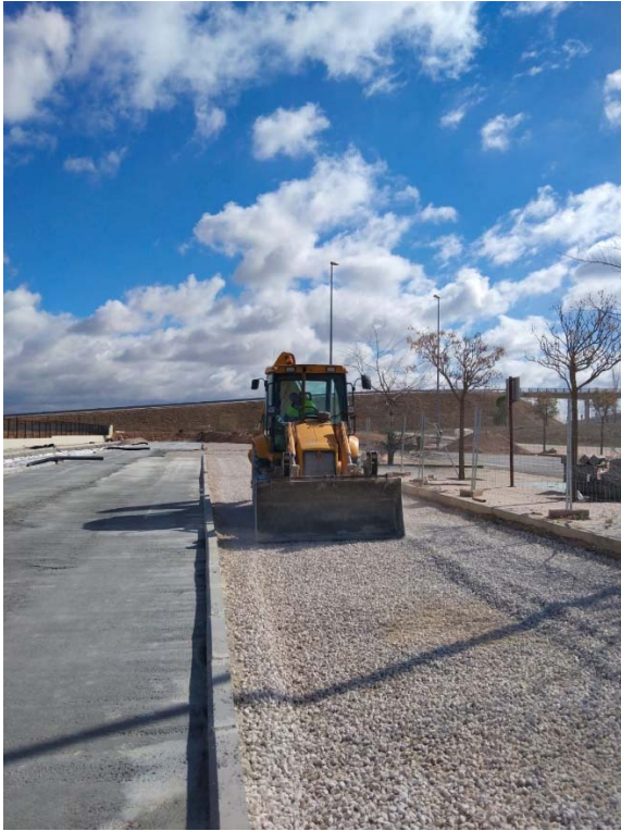
15. Sub base aparcamiento hormigón drenante parking vial D
