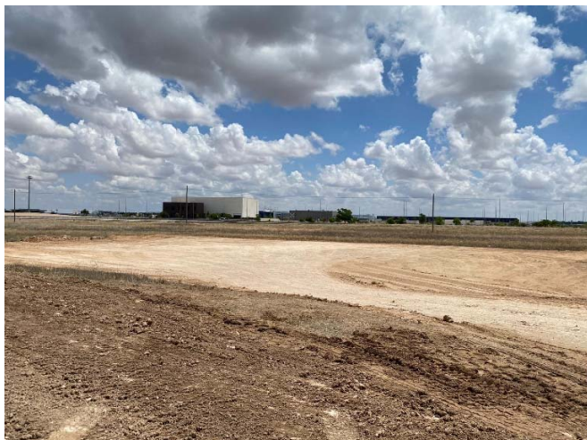
1. Zona balsa. Desbroce de la parcela
