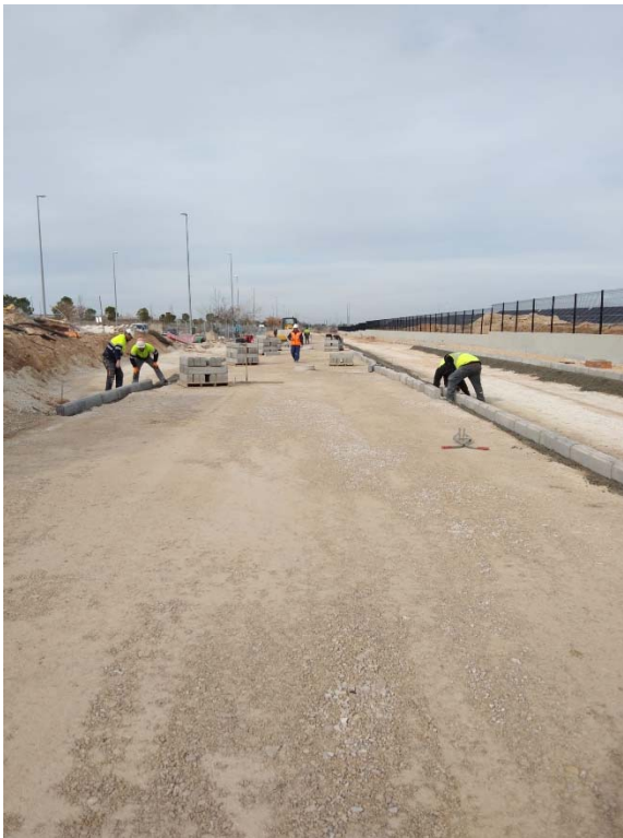
16. Colocación bordillo parking vial D
