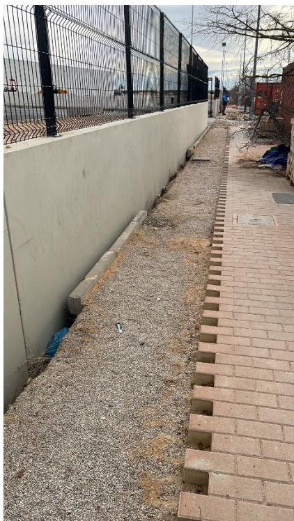
36. Reposición de acerado vial J.
