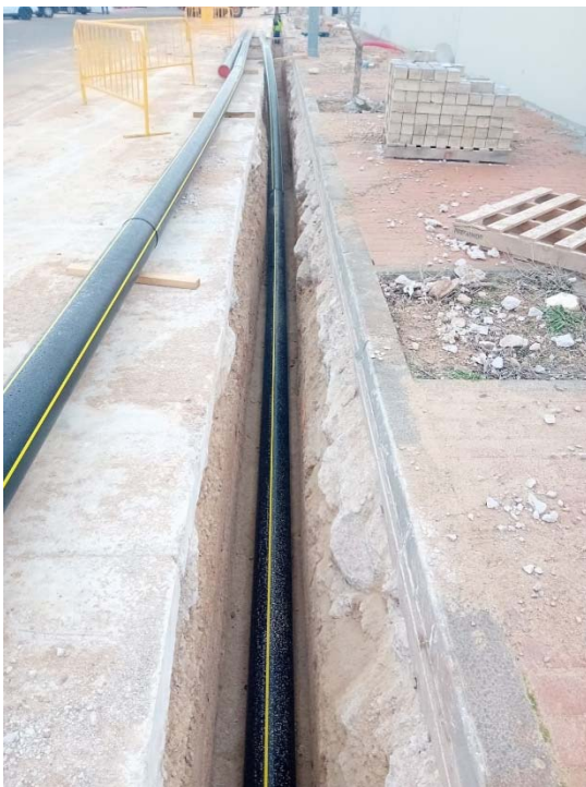
20. Colocación tubería gas vial J
