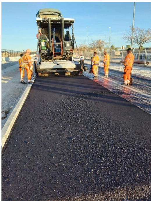
35. Asfaltado calle del parking vial D.
