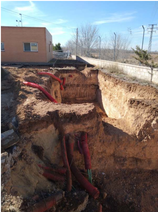
2. Excavación Depuradora y arquetas depuradora.
