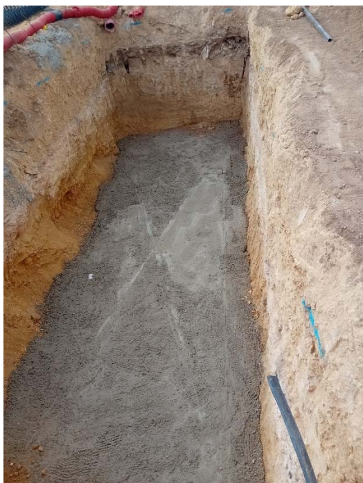
29. Fondo de excavación y hormigón de limpieza de depuradora.
