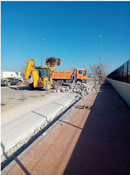
24. Picado hormigón para zanja gas. Vial J.
