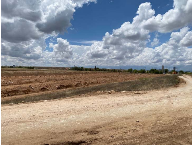
4. Zona balsa. Desbroce parcela
