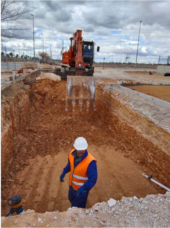
33. Excavación depósito drenante parking vial D.
