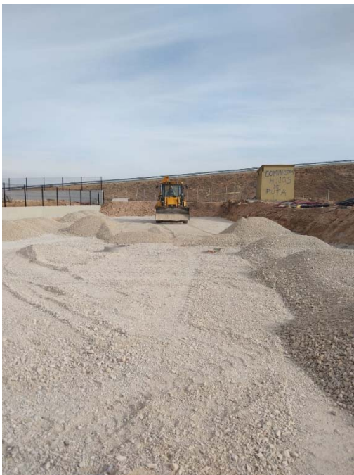
28. Extendido sub base parking vial D.
