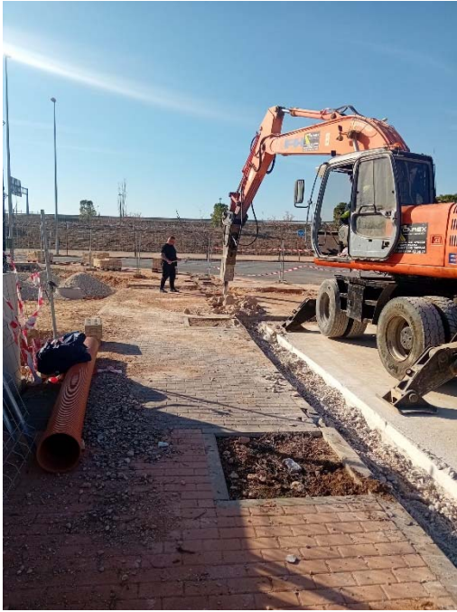
7. Picado zanja gas cruce vial J con vial D
