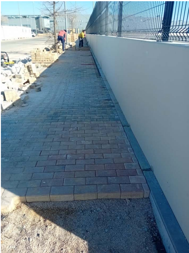
32. Reposición de adoquín vial J.
