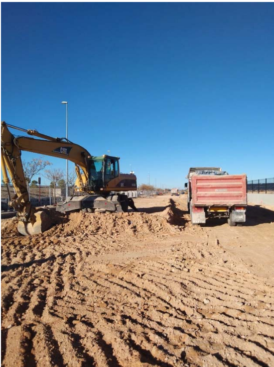
4. Excavación zona parking vial D
