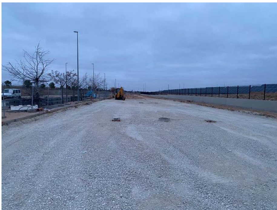
10. Extendido zahorra parking vial D
