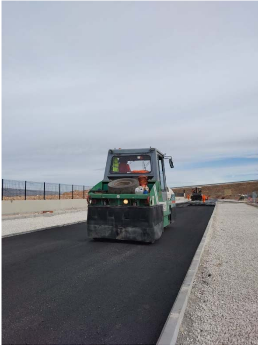
1. Asfaltado parking vial D
