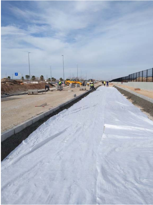
23. Colocación de geotextil parking drenante vial D
