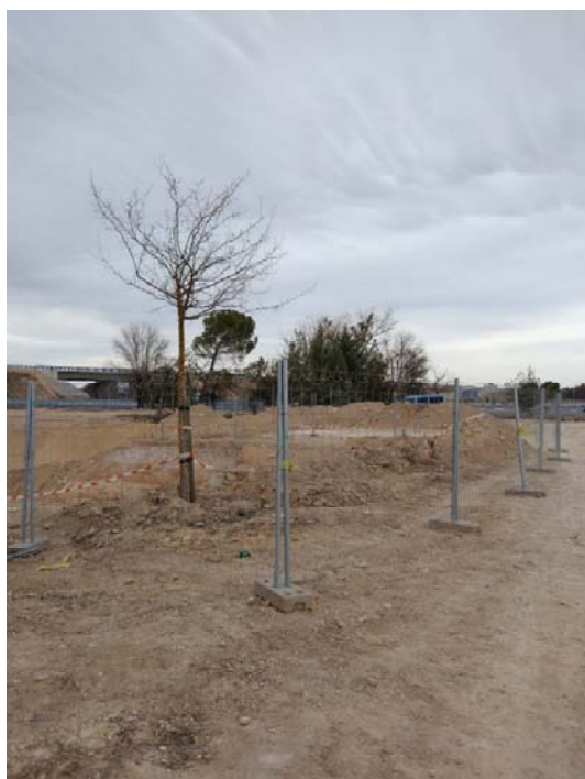
30. Límite camino con balsa. Vallado obras. Balizamiento y protección árbol.
