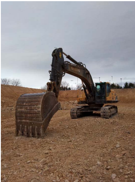
38. Excavación balsa. La máquina cuando termina se queda en el tajo.
