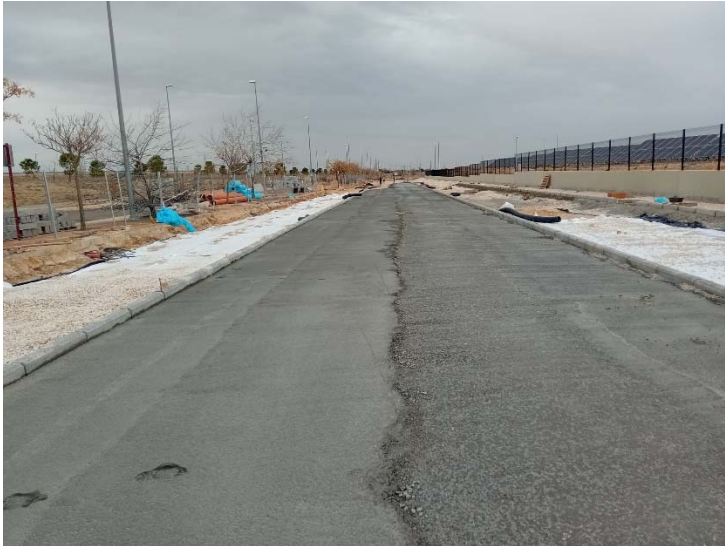
31. Hormigonado calzada parking vial D.
