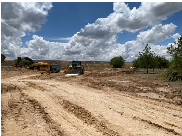
7. Zona balsa. Inicio excavación vaciado
