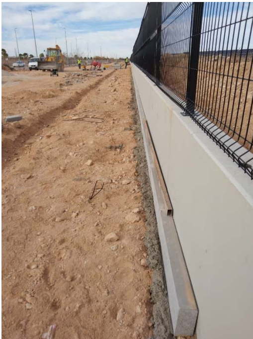
8. Colocación bordillo acera permeable parking vial D
