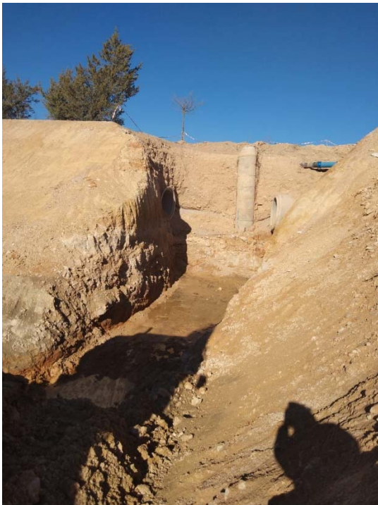
22. Arqueta existente demolida. Entronque con balsa.
