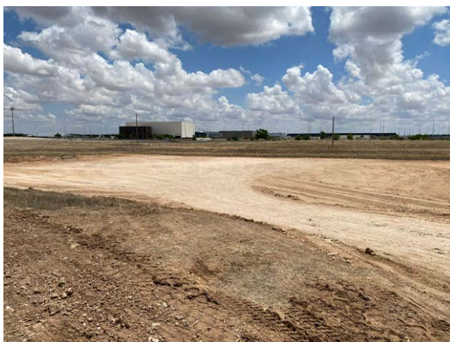
3. Zona balsa. Desbroce de parcela
