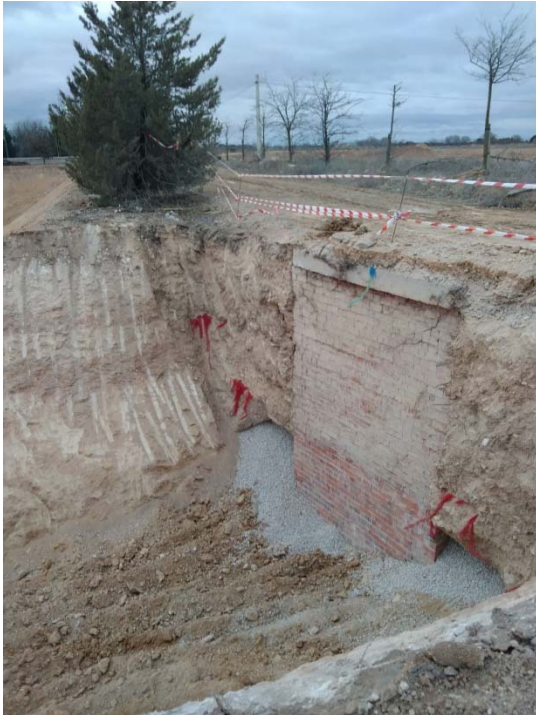
21. Excavación arqueta de entronque colector a balsa. Arqueta existente.
