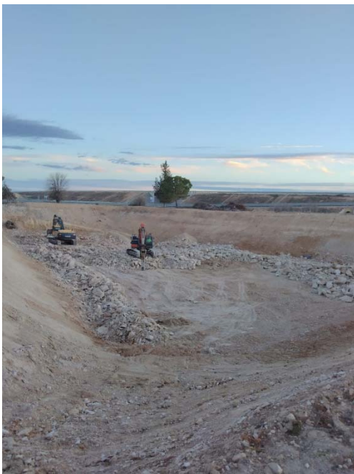
6. Picado fondo de excavación balsa
