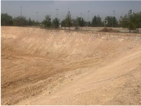
1. Excavación balsa.
