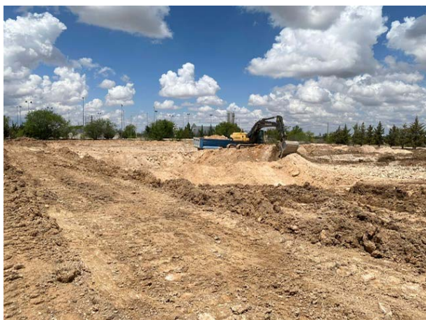
9. Zona balsa. Inicio excavación vaciado
