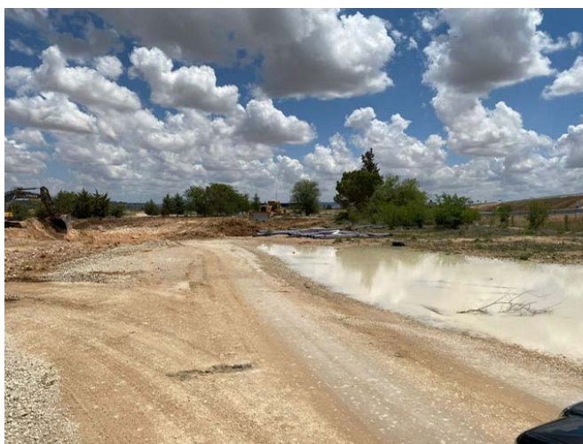
2. Zona balsa. Desbroce parcela
