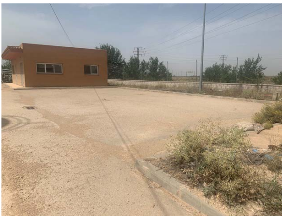
5. Parcela para ubicación de la depuradora compacta.
