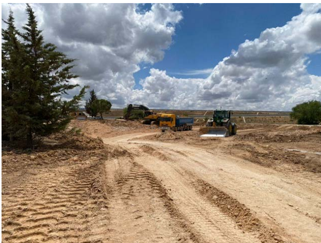
6. Zona balsa. Inicio excavación vaciado.
