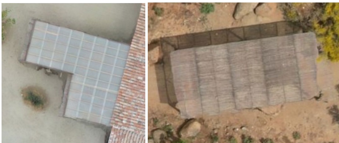
Vista aérea de pérgola impermeabilizada TPVD01 (izq.) en comparación con pérgola sin impermeabilizar TPUR13 (dcha.)
