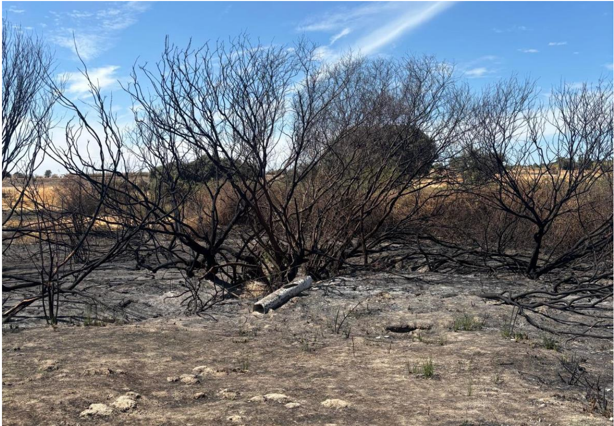
Figura 8. Tubería de fibrocemento aflorada tras el incendio al norte del arroyo Zarzueleja. Fuente: elaboración propia durante la visita llevada a cabo el 14 de octubre de 2025.
