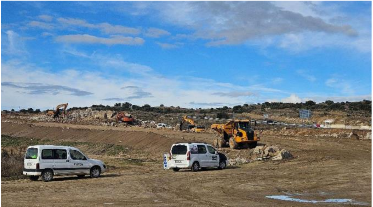
Figura 9. Proyecto en ejecución situado al noroeste, fuera del límite del PSI. Fuente: elaboración propia durante las visitas mensuales (diciembre 2025).
