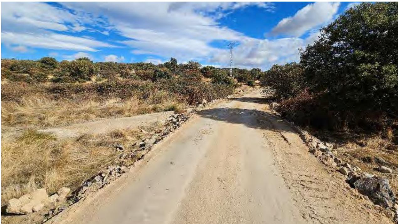
Figura 10. Compactación de caminos en el interior del ámbito del PSI (octubre 2025). Fuente: elaboración propia.
